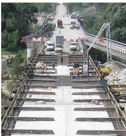
Sopra: uno dei cantieri sulla Salerno-Reggio Calabria
